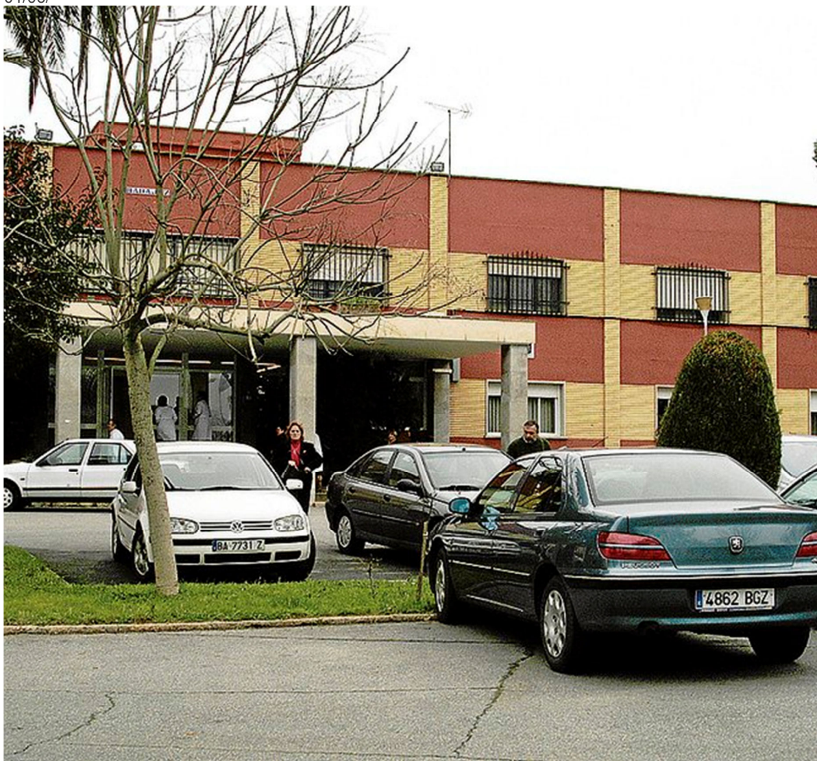
Fachada de las instalaciones del centro sociosanitario. - Foto: EL PERIODICO
